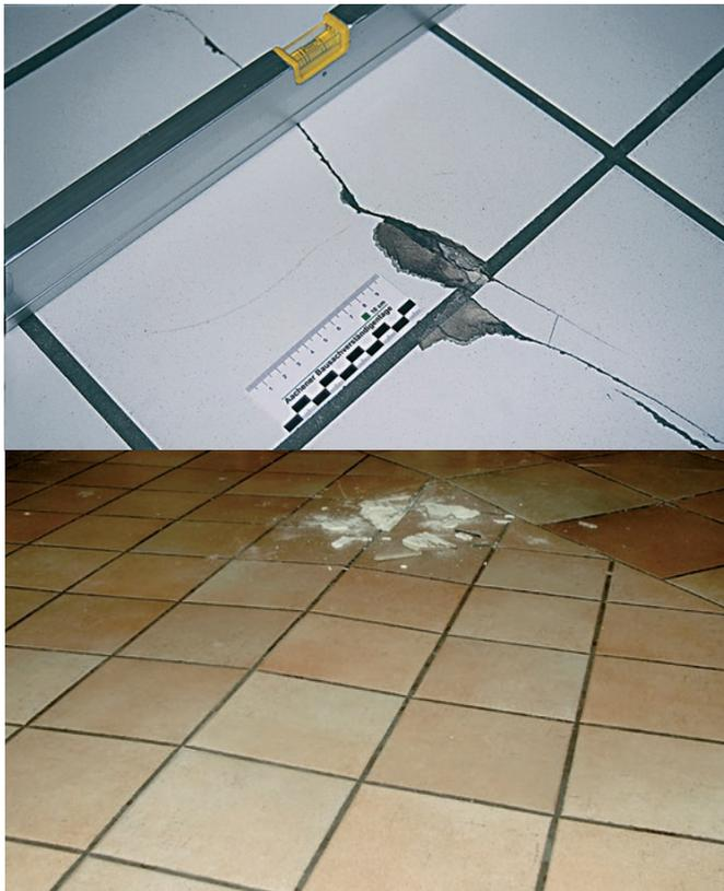
Les contraintes dues à des coefficients de dilatation différents du revêtement et du support ou en raison de chapes fraîches ou désolidarisées conduisent à des fissures ou soulèvements du revêtement.
