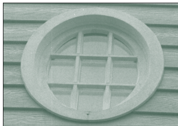
Finition contour fenêtre avec application profil de recouvrement.
