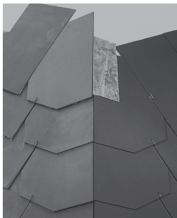
Arêtier avec ardoises taillées en biais
