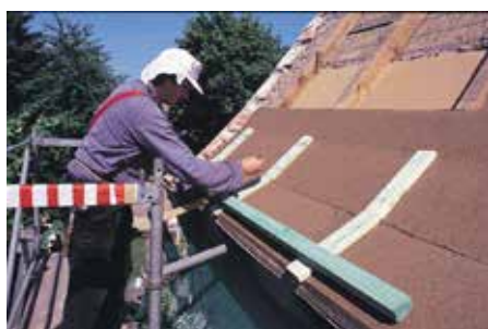
Photo à gauche: En cas de coyaux au pied de versant, il faut tenir compte de la brisure au niveau du raccord rainure-langnette horizontale. A cet effet, la première rangée est découpée à la largeur correspondante (du bord avant du chevron jusqu'à la brisure).
