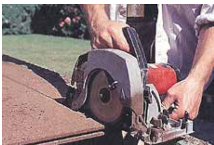
Photo à gauche: coupe à dimension du panneau Celit 4D.
